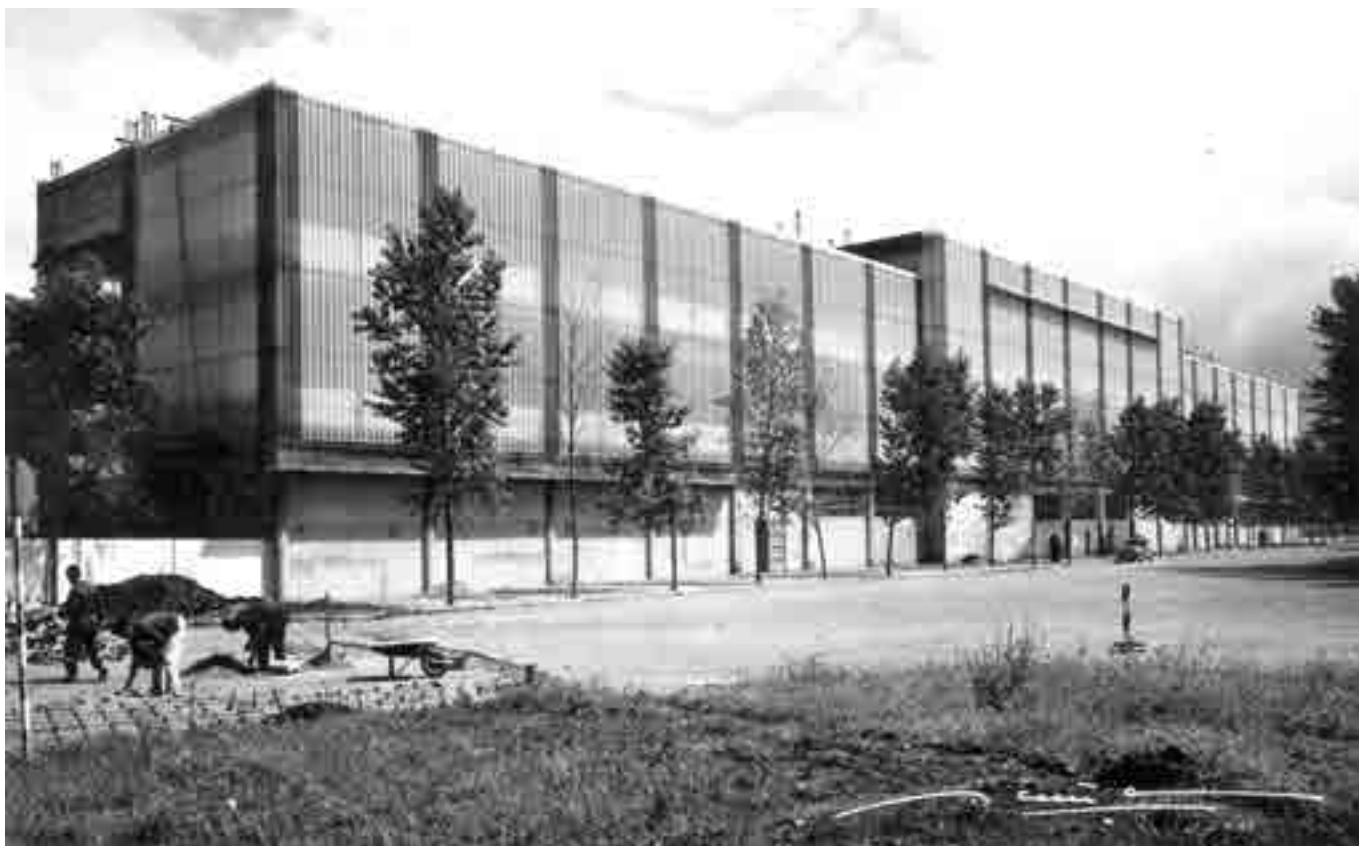
Trabajos de construcción del pabellón central de la Feria de Muestras en la tribuna oeste del estadio de El Molinón (Acuña, archivo de la Cámara de Comercio de Gijón).
