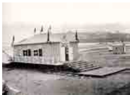
Caseta de baños utilizada por Isabel II durante su estancia en Gijón en 1858 (Alfredo Truan, Patrimonio Nacional).
